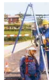
密閉空間設備 三腳架、吊機、 氣體、測試儀
